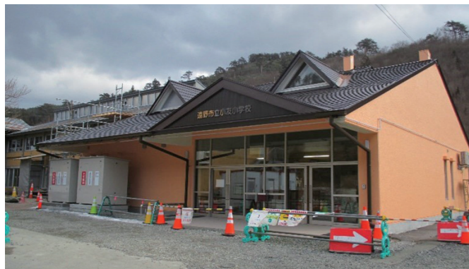
遠野市の長寿命化 計画に基づく遠野 市立小学校の工事
