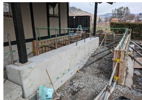
スロープ（工事中）
