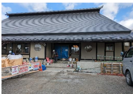
食堂厨房正面（工事中）
