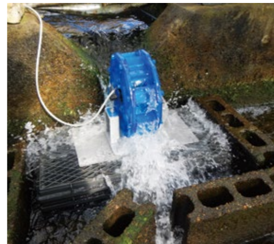
小水力発電実証事業 (達首部地区)
