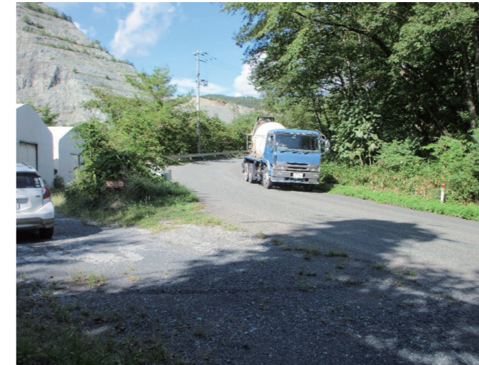
急カーブ中の勾配が逆勾配でスリップ事故が絶えない市道才の神線
