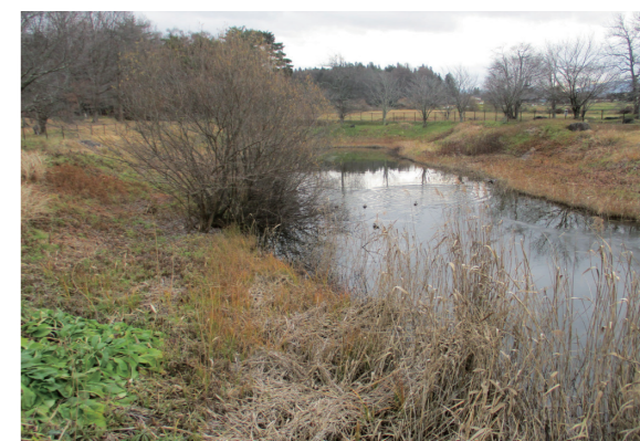
整備が必要な調整池
