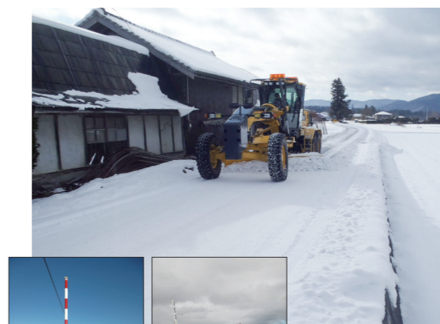
市民の足を守る早朝からの除雪作業
