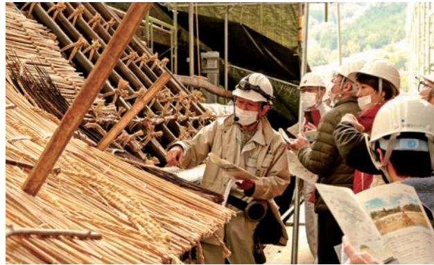
工事担当者からの説明を受け、茅の修復状況を見学する参加者
