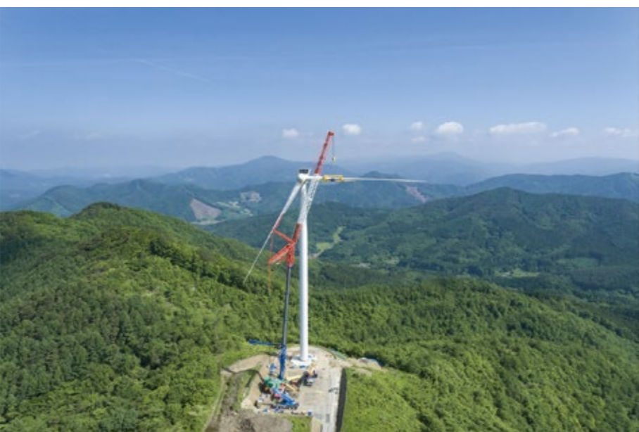
組立作業中の住田遠野ウインドファームの風車
