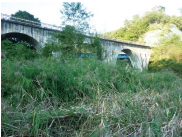
詩人・宮沢賢治が河原に寝転んで空を見上げ、銀河鉄道を想像した達曾部川橋梁。草や樹木が繁茂し、撮り鉄ファンのためにも環境整備が望まれる。
