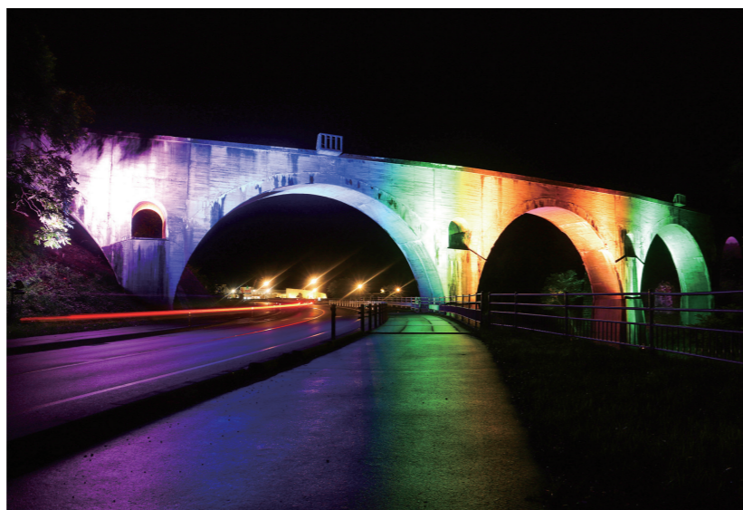
日本夜景遺産に認定されためがね橋（宮守川橋梁）
