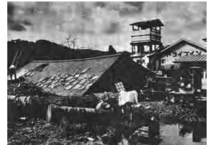
洪水により倒壊した家屋 (宮守町鱒沢)
