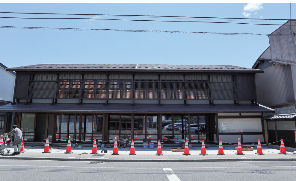
完成間近い「こども本の森遠野」の外観
