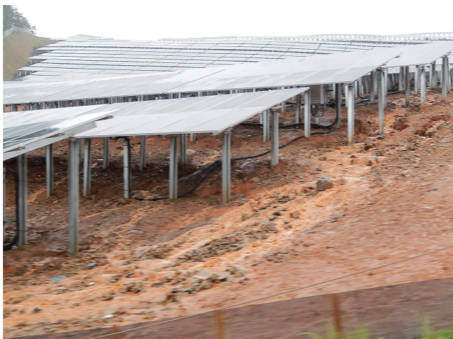
当日の雨で、むき出しとなった地面を雨水が流れだしていた
