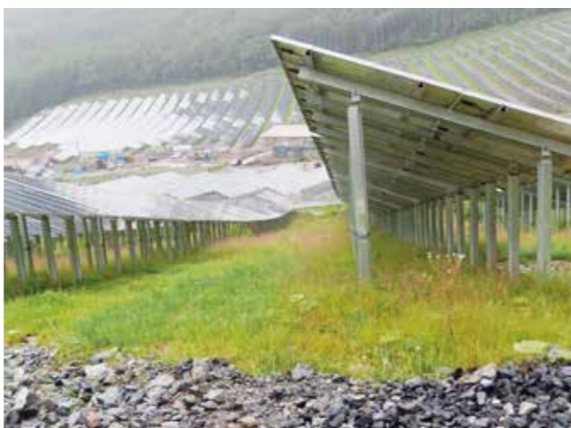
濁水対策のため緑化を進めている
