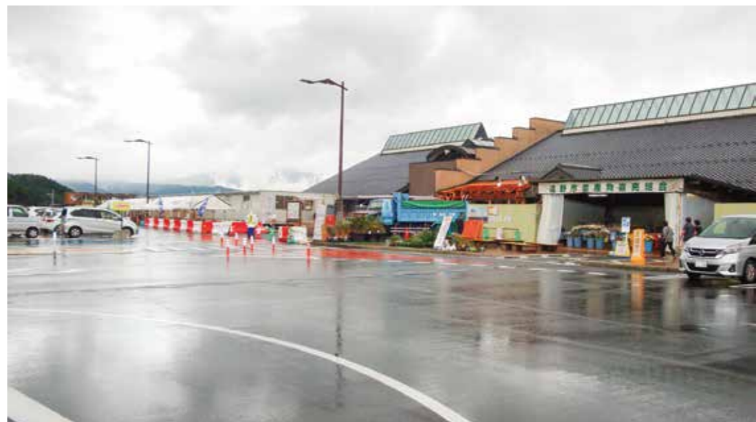
改修工事が始まった道の駅遠野風の丘
