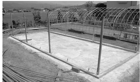
コンクリートの床にハウスを建設するだけで簡単にできる簡易牛舎(建設中)
