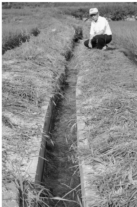
地域住民が自ら整備した水路
