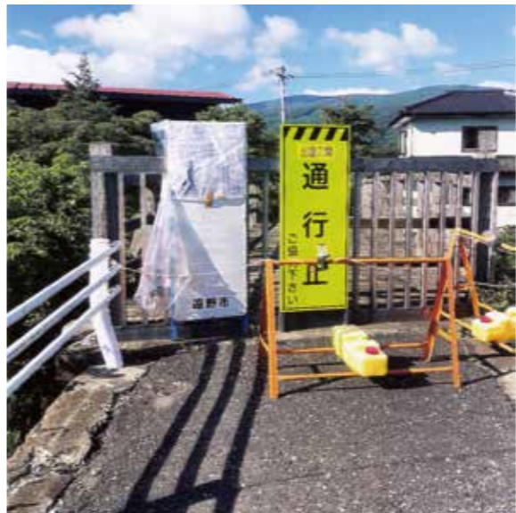
修繕が決まった橋りょう
