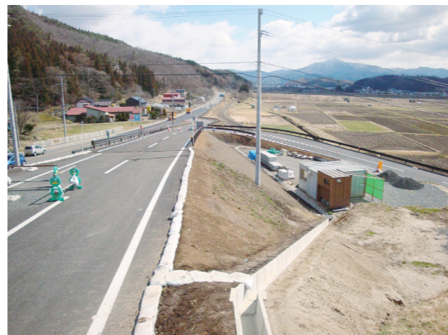
風の丘進入路整備により市道が切り替えとなった
