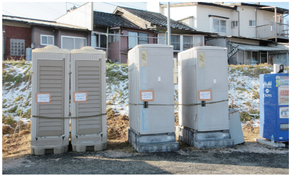
冬季間閉鎖の仮設トイレ、このままでいいのでしょうか
