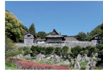
修理前の千葉家住宅外観
