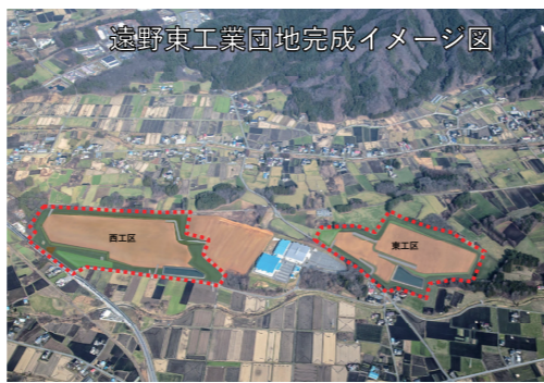
順調に進んでいる東工業団地の造成工事
