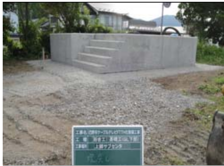
サブセンター基礎工事(上郷)
