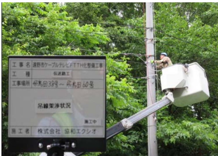
光ファイバケーブル設置作業
