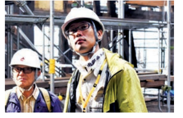
工事中の千葉家で説明する黒田学芸員
