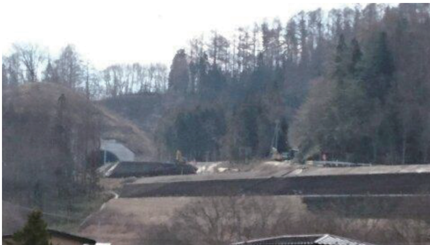
平成30年開通に向け工事が進む釜石自動車道（鍋倉トンネル付近）
