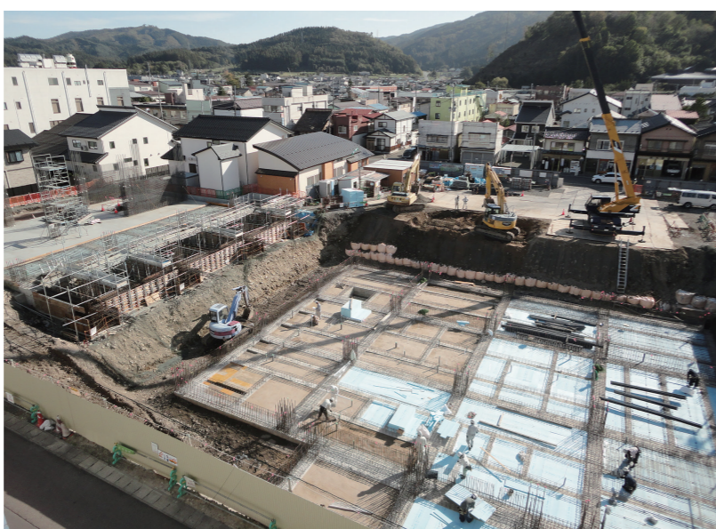
現在整備中の新庁舎
