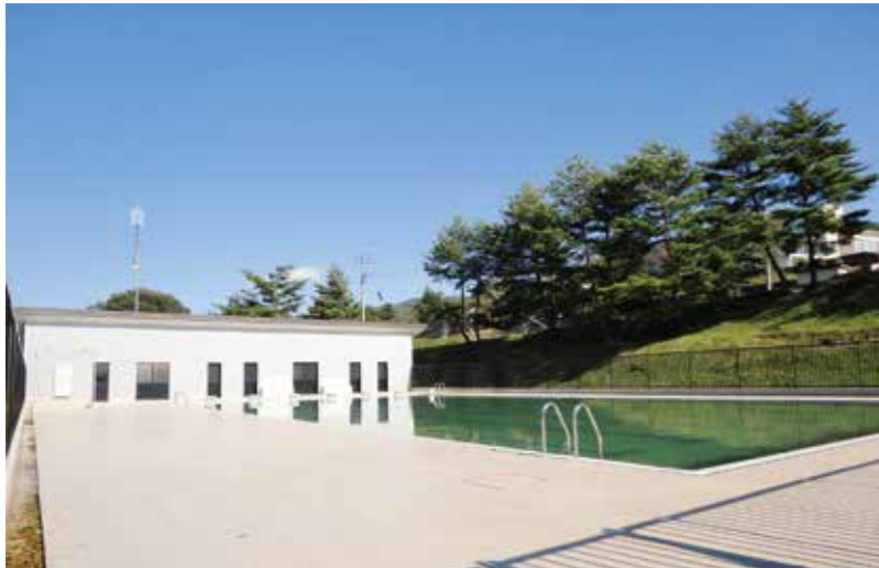
8月に落成した遠野西中学校のプール
