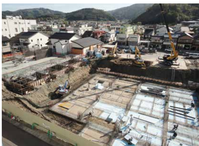
現在整備中の新庁舎
