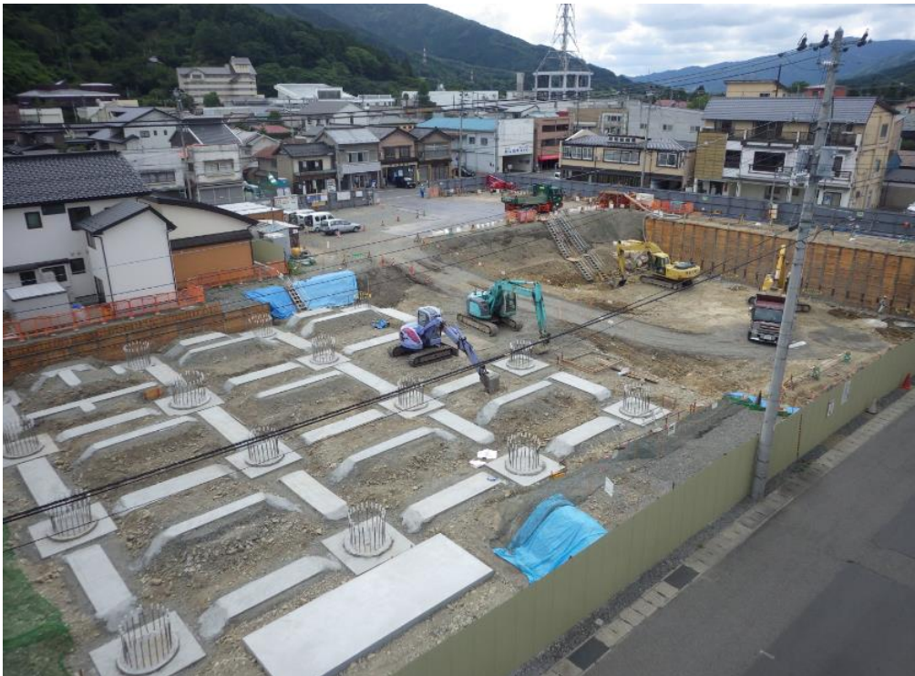
とぴあ屋上東側から撮影（7 月 26 日）。写真左側が基礎部分、右側が地下工事に向けて掘削作業中。工事は予定どおり順調に進んでいます。
