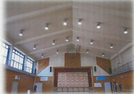
照明設備を更新し、明るくなった遊戯室
