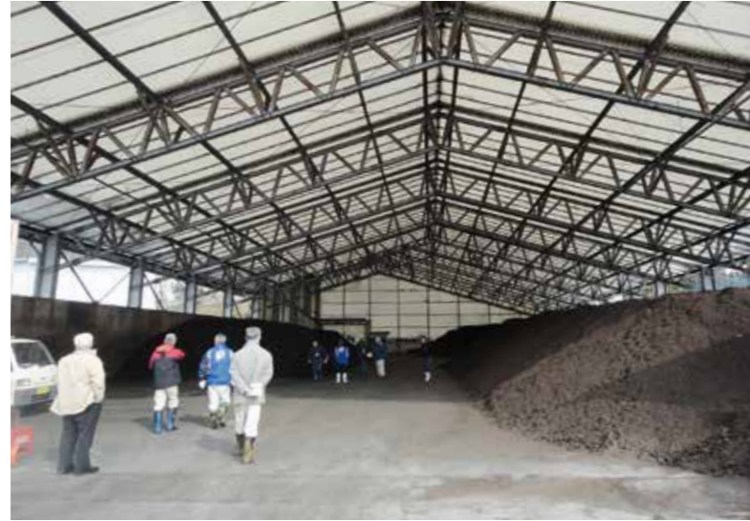
市営堆肥センターのストックヤード
