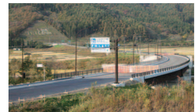
12月完成・開通予定の東北横断道遠野IC付近
