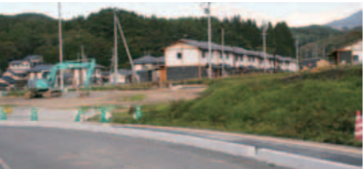
工事が進められている稲荷下地区
