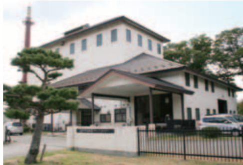
清養園クリーンセンターごみ焼却施設
