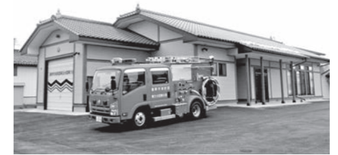
供用開始した同センター
