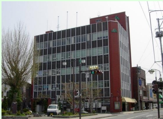
施工前（5階建） ※旧JA遠野本店
