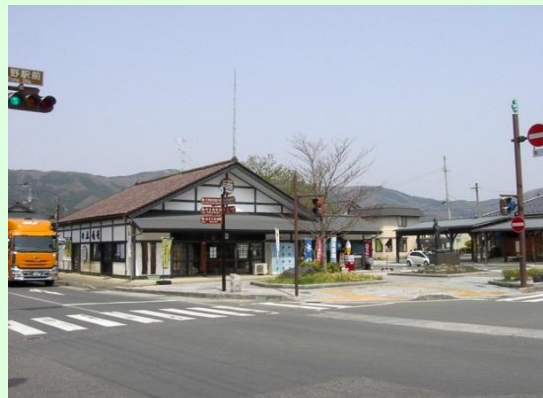
施工前 ※日本通運遠野
