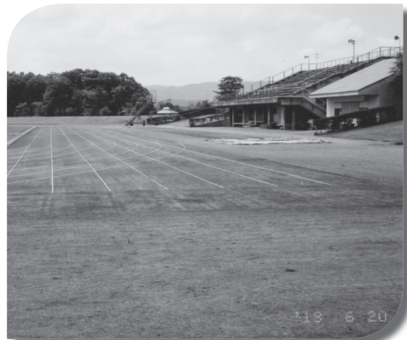
全天候舗装整備が望まれる市陸上競技場トラック
