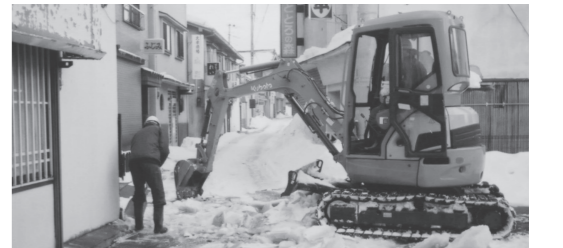
市街地の狭い道路の除雪風景
