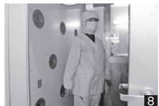
6_調理器具は全てオール電化。非常用発電機を備え、災害時の炊き出しにも対応します 7_1日2,500食の調理能力を持つ調理場 8_体に付着した埃などを除去するエアーカーテン。衛生面も改善されました
