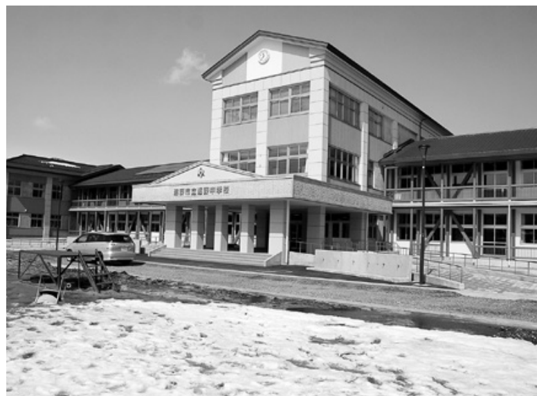
新設された遠野中学校
