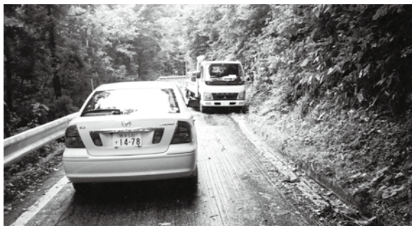
早急な整備が望まれている立丸峠付近
