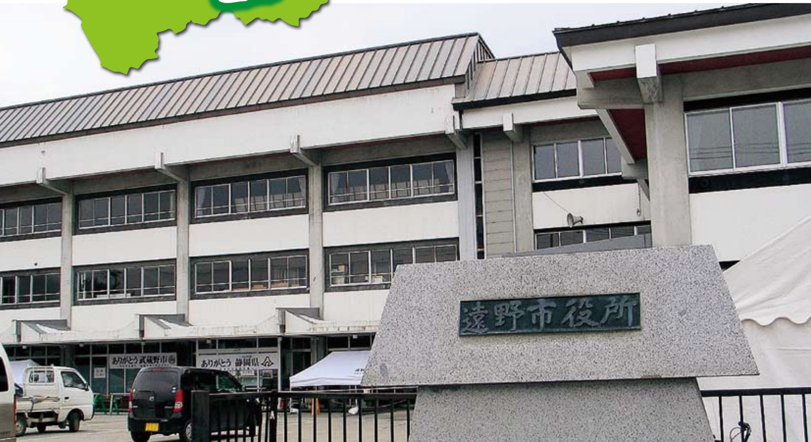
東日本大震災での被害により使用不可能となった遠野市役所中央館
