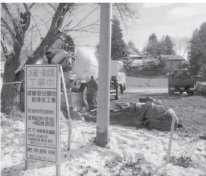
市有地が分譲され、工事が始まった達曽部分譲地
