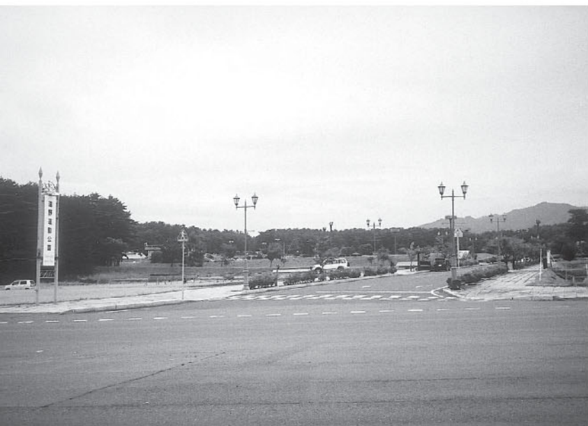
後方支援基地の中心となる予定の遠野運動公園付近
