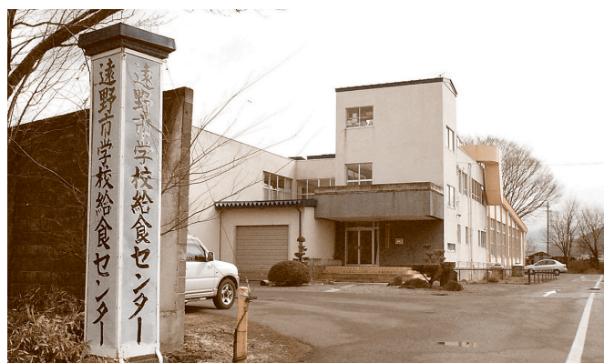
▲老朽化し整備が検討されている給食センター
