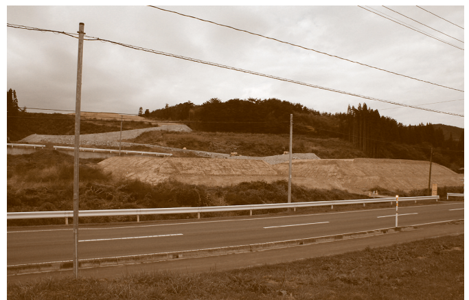
▲工事が始まった宮守インターチェンジ
