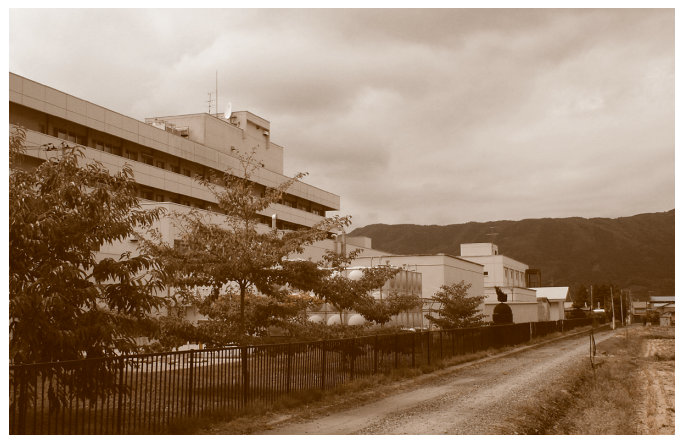
▲早期整備が望まれる遠野病院周辺道路
