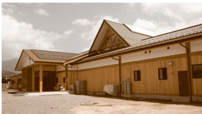
青笹保育園にもペレットボイラー導入予定
