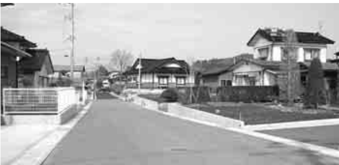
整備中の稲荷下第二地区
