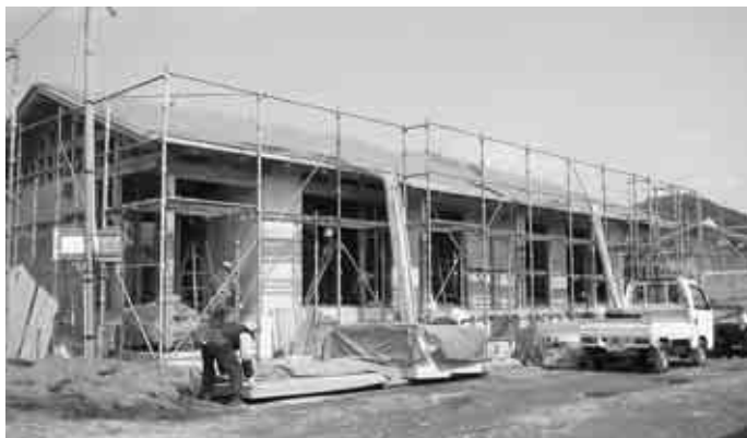
八幡住宅の建て替え工事が始まっている
