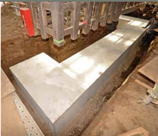
出来上がった建物本体の基礎
