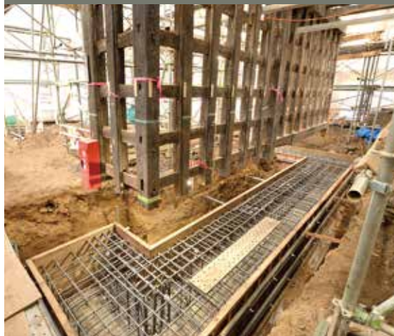
建物を仮設材で支え、地中に基礎をつくる
