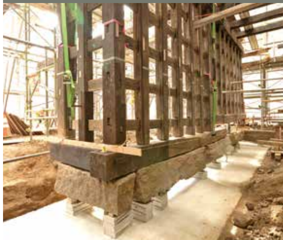
基礎の上に礎石を戻し、高さ調整
