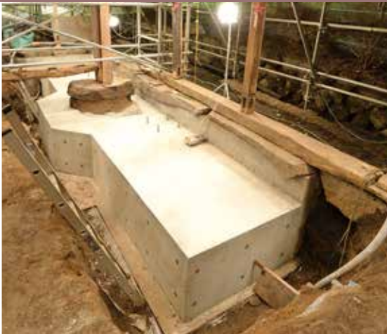
補強鉄骨柱の基礎が完成
