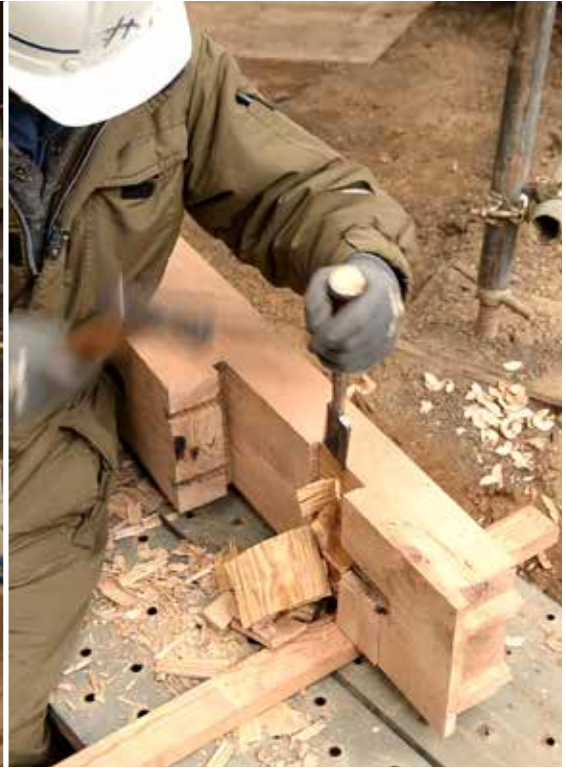
② 新材を古材の形に合わせて加工
