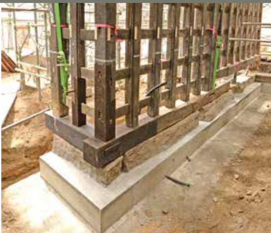
調整材と礎石の下部をモルタルで固めて完成
