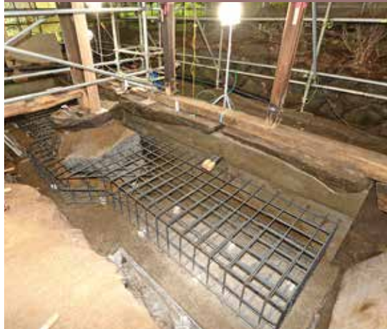
補強基礎の鉄筋を建物基礎と連結
