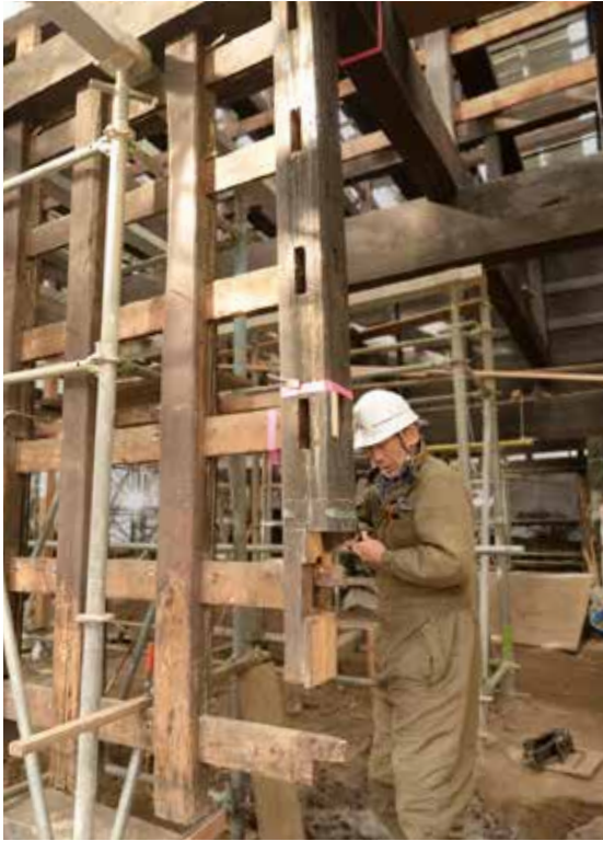
① 傷んだ柱の根本を切り、継手加工
