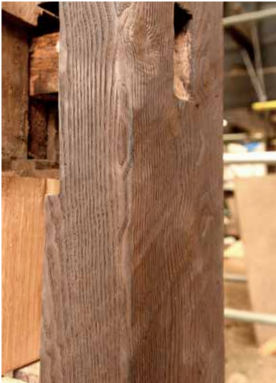
③ 古材のまさかりによる加工痕を再現 表面を焼いて着色、風化具合再現
