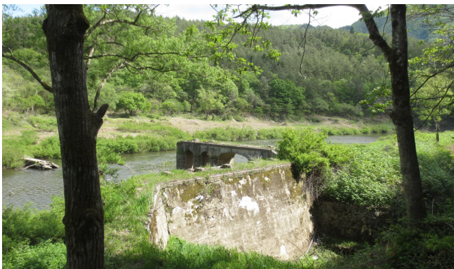
▲黄金山発電所の取水口跡
