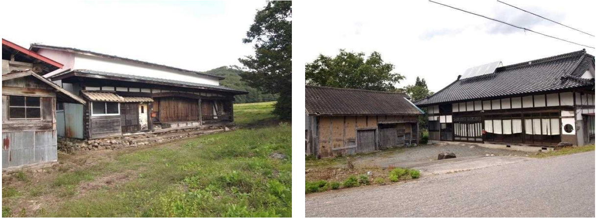
集落内にある空き家
