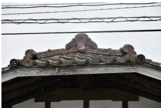
写真 2-58 カブト屋根(ドイツ破風)
