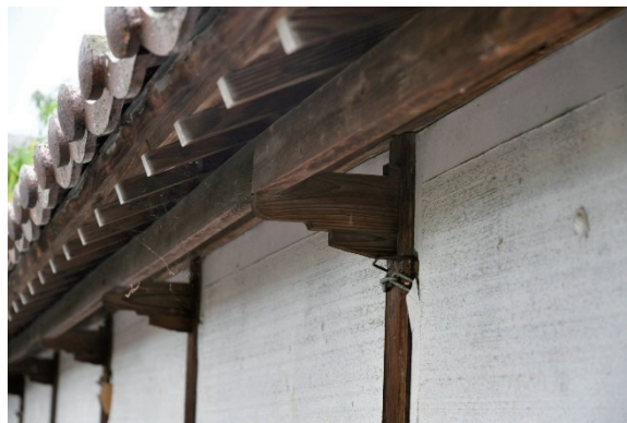
写真 2-65 築地塀の屋根を支える線形付き腕木
