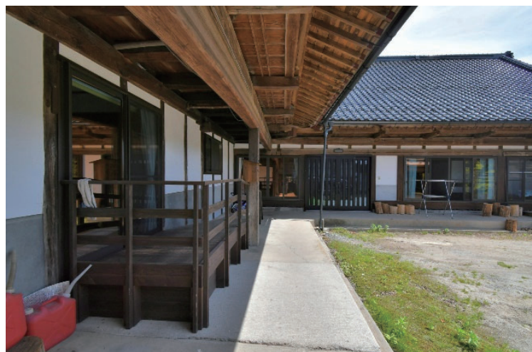
写真2-69 厩を居室に改造し、軒下に斜路を新設した例
