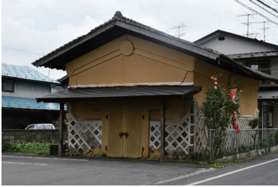
写真 2-38 ナマコ壁だけ仕上げた蔵
