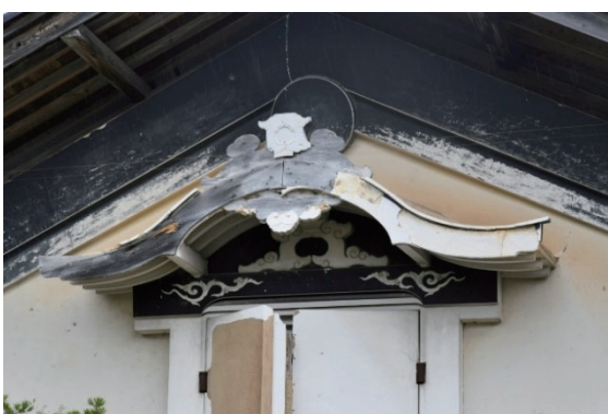
写真 2-37 唐破風や窓枠に鏝絵が施されている
