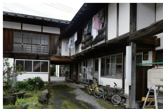
写真 2-31 カグジ(裏庭)に出桁の2階建てをL字状に接続
