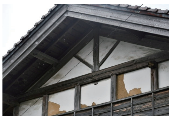
写真 2-59 洋小屋組(トラス)を妻壁に顕した町家
