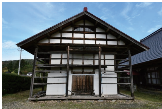
写真 2-51 総漆喰仕上げの出桁による3階建ての納屋
