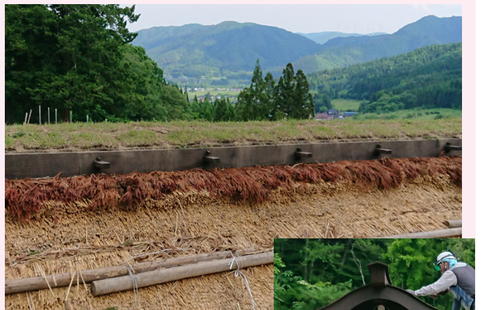
▲馬屋部分の屋根の上部。 この日は仕上げ前のため、職人が使う丸太足場がまだ残されている。
