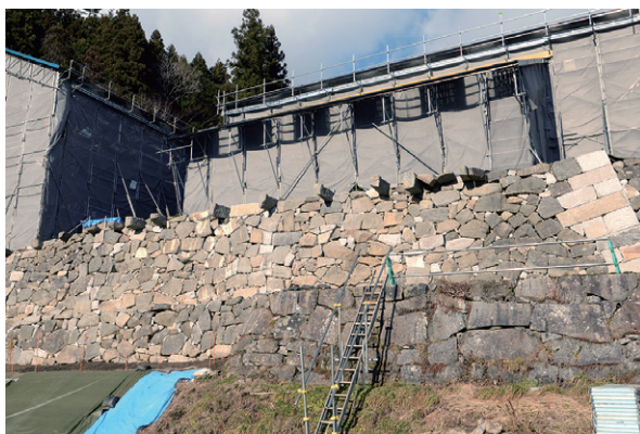
写真 4-1 修理を終えた主屋前面石垣
